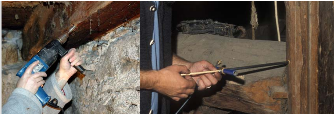
Probenentnahme mittels Fräsbohrer bzw. Bergung eines Bohrkerns (Hohlbohrer)
